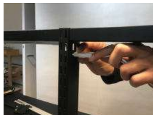
(5) この時、カチッと音がするまで差込むようにしてください。
