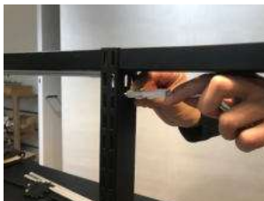
(4) 穴を通したコード用からカプラを出し、となりの照明のカプラに差込みます。
